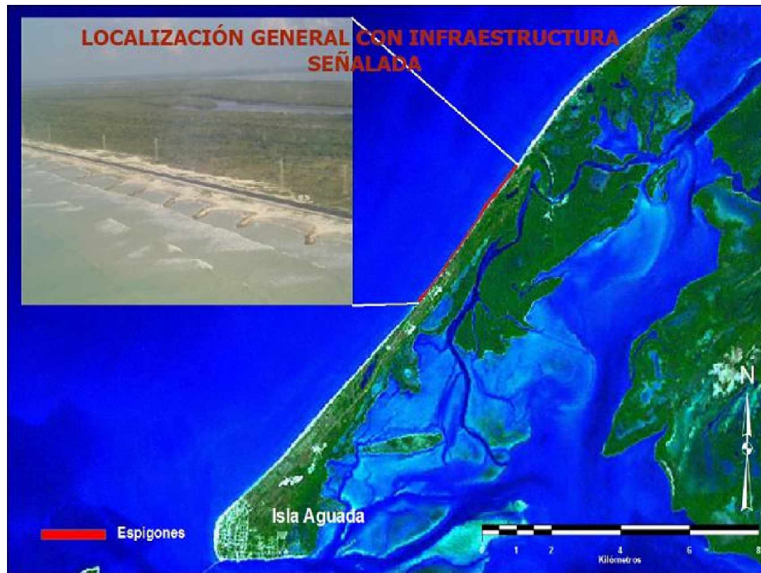
Figura 2a. Rompeolas (espigones tipo “a”) colocados perpendicularmente cada año en el área de La Barrita en Isla Aguada.
