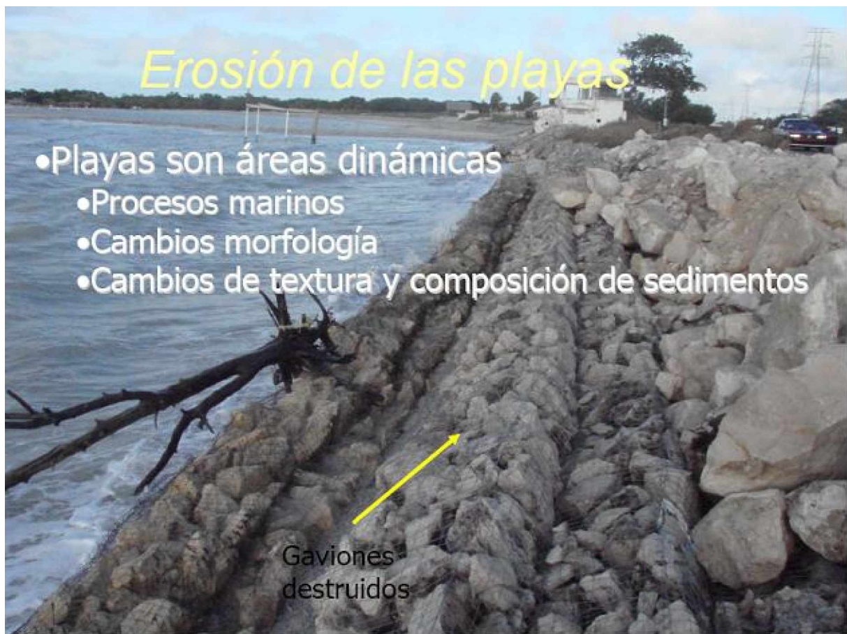
Figura 1. Gaviones colocados y destruidos cada año en el área de Bahamita en Isla del Carmen.
