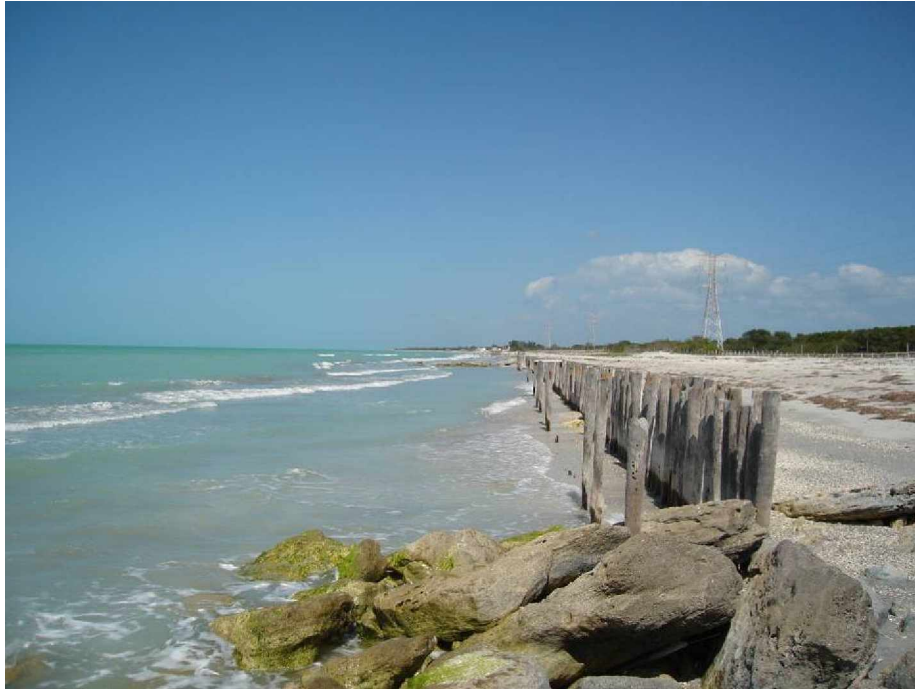
Figura 2b. Rompeolas (espigones tipo “B” ya sin piedras en el interior) colocados paralelos a la línea de costa en el área de San Nicolás en Isla del Carmen.
