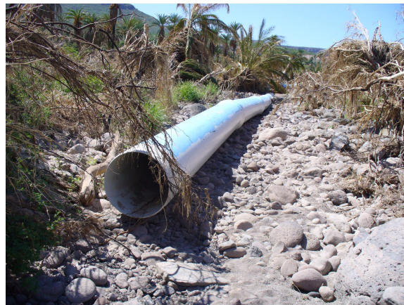
FIGURA 58. ACUEDUCTO QUE DESVÍA EL AGUA DEL HUMEDAL PARA USO HUMANO, IMPACTADO POR LA CORRIENTE DEL HURACÁN JIMENA, SEPT. 2009
