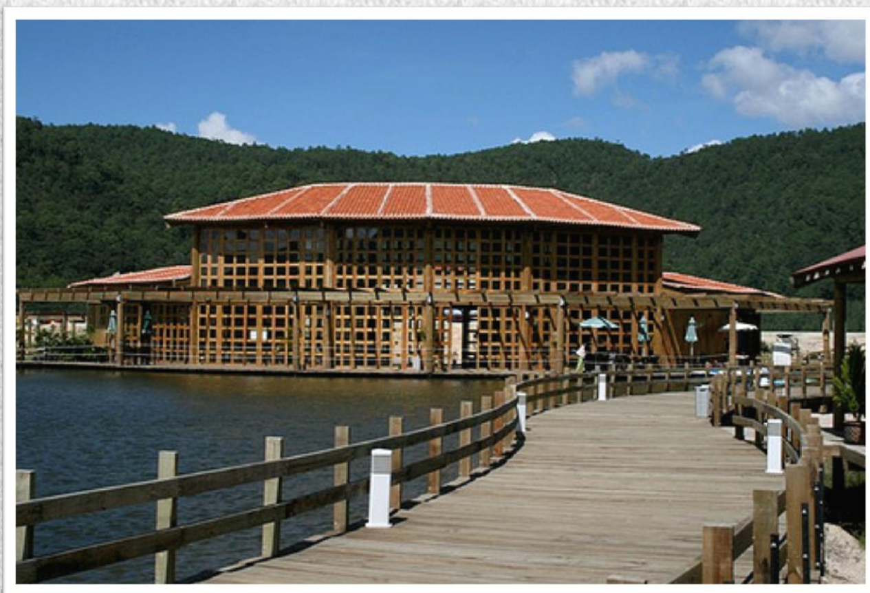
Figura 11. Subzona de recreación. El hábitat ha sido totalmente modificado.
